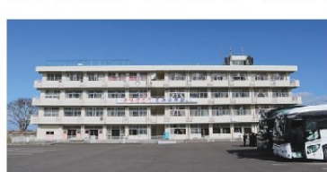
震災遺構仙台市立荒浜小学校
